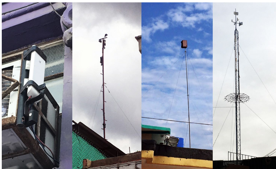
NANOS de usuarios con diferentes estructuras anti-robos. NANOS of users with different anti-theft structures.
